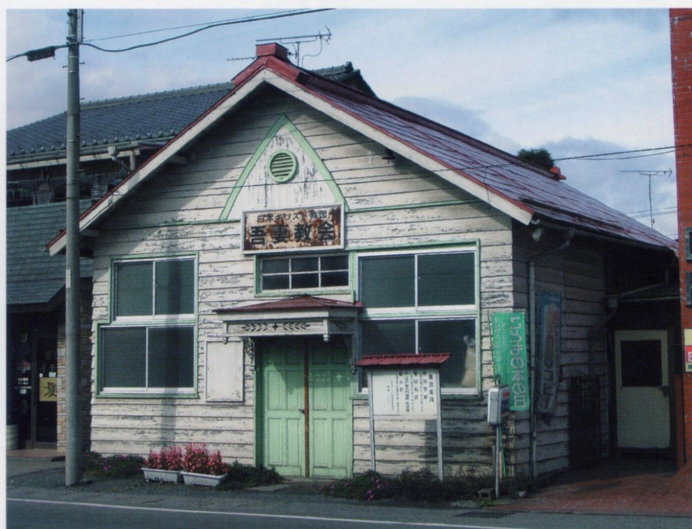
4-16 1917 (大正6) 年に建てられた吾妻教会旧会堂
